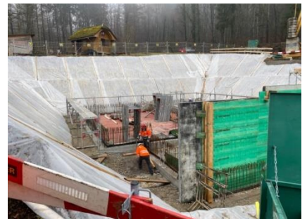
Neubau Reservoir Lätten
