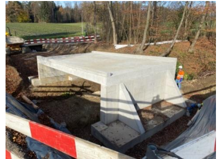
Neues Brückenbauwerk über den Heubergbach
