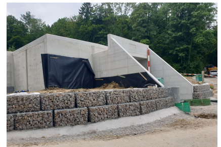
Neubau Reservoir Lätten
